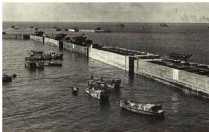
Dessa block fylldes med vatten och sänktes ned på botten och bildade en hamn
