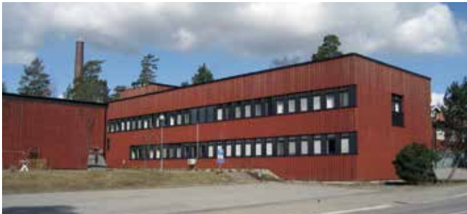
FTTS nybyggda skolhus
